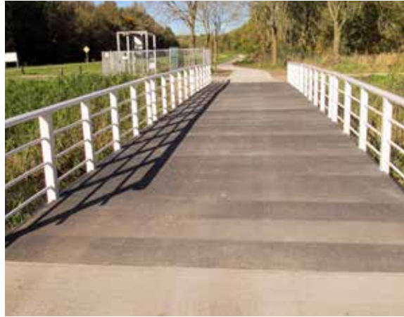
Nach der Sanierung mit krafton®
