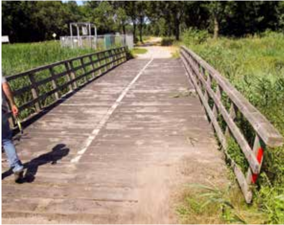
Vor der Sanierung mit krafton®
